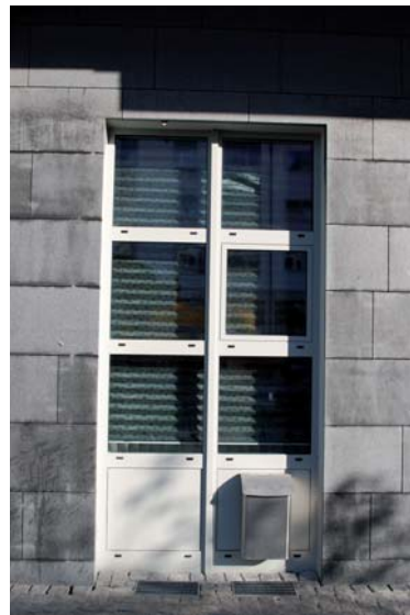
Entréer och fönster med direkt kontakt med gångbanor upplevs av de boende som störda av förbipasserande.
