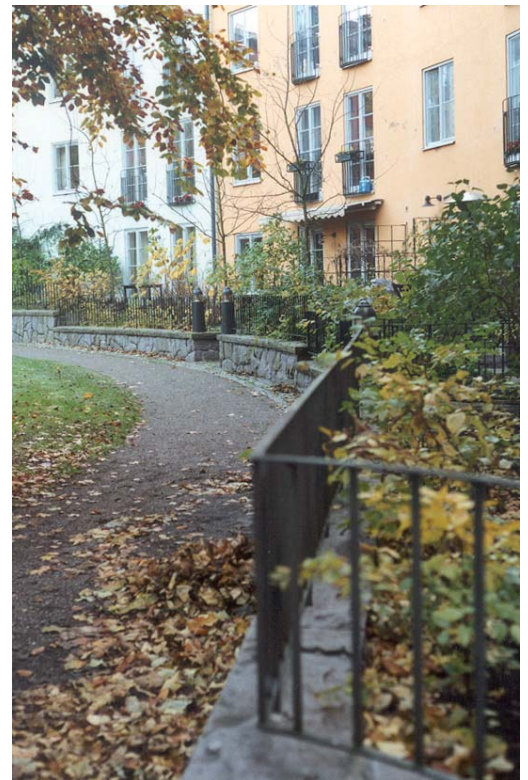
Förhöjd husgemensam och privat? förplats till husen i St Erik i Stockholm. Fint bearbetad kant med stensarg och metallräcke. Lugn bakomliggande fasad.
