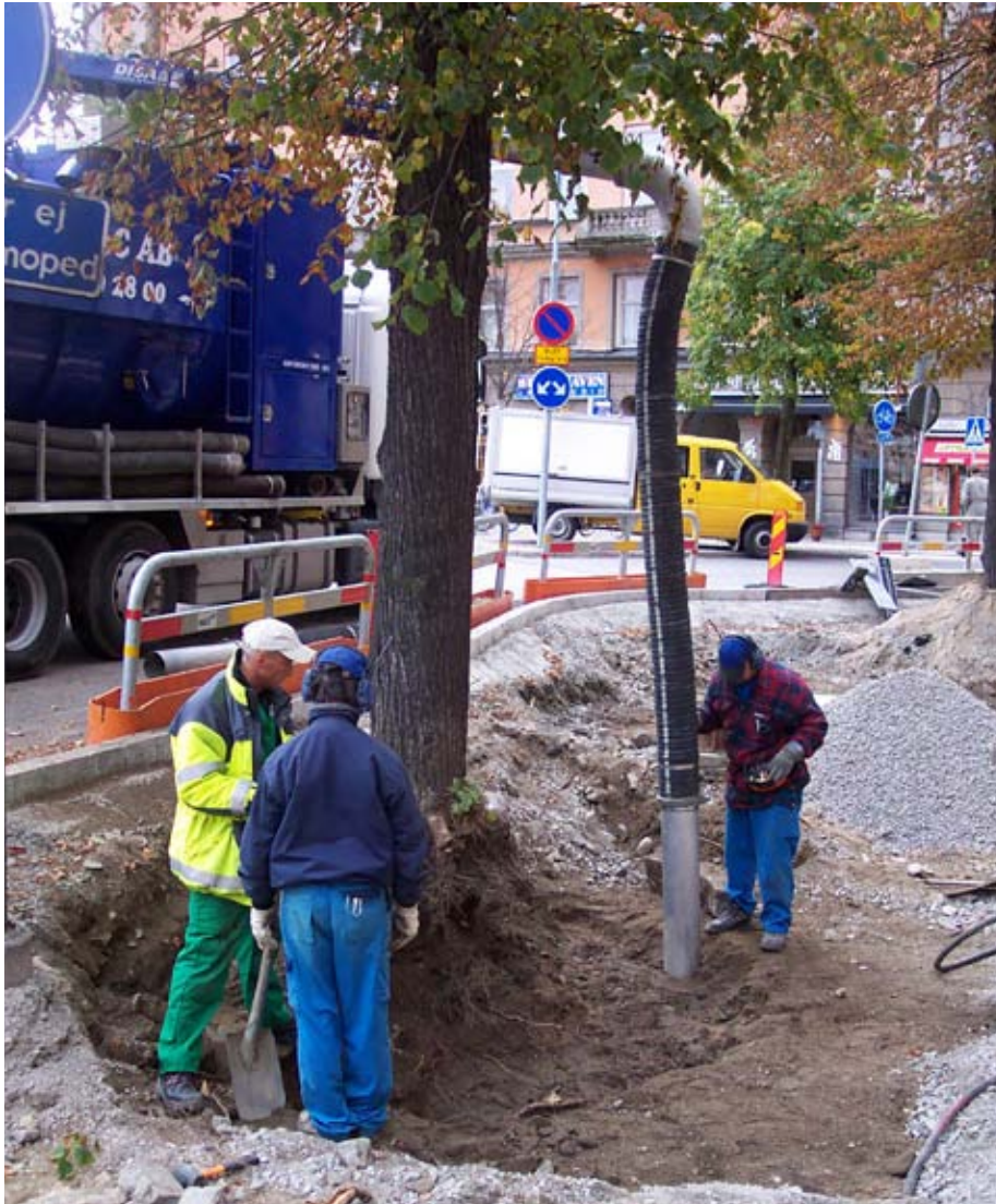
Rotvänlig schakt vid ett gatuträd på Kungsbrogatan i Stockholm i augusti. Notera de bruna bladen som visar på en för tidig bladfällning och torkskada. (Foto: Örjan Stål)
