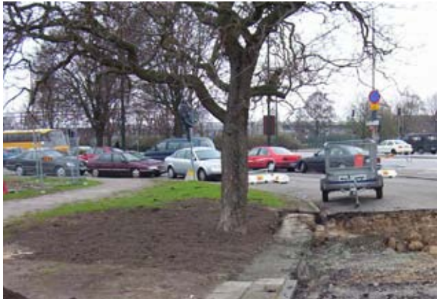
Befintliga hagtornsträd i Malmö vid en gammal väg. Vägen ska tas bort och ett sammanhängande parkstråk ska byggas. Vid provgrävning påträffas inga trädrötter i vägbanans överbyggnad. Maskinchakt kan då användas för att ta bort resterande vägöverbyggnad.
