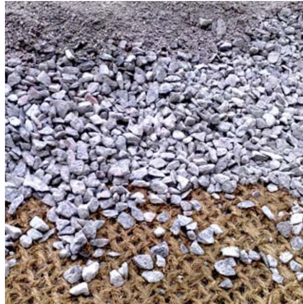
Kokosnät som materialskiljande lager vid ytbeläggning av grus.
