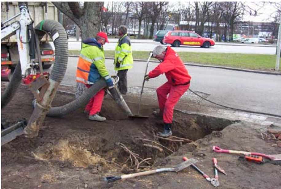
I känsliga områden med mycket trädrötter används rotvänlig schakt. Här med vakuumsug samt tryckluftslans. Metallansen används både till schakt och till luckring.
