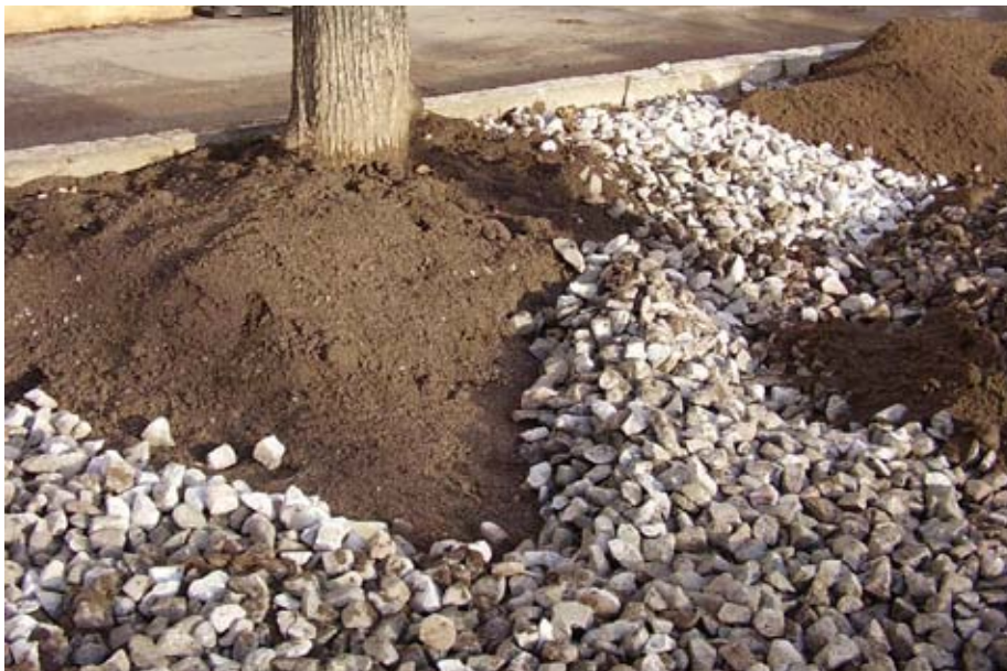
Luftigt lager av makadam 32-63 mm läggs ut på luckrad terrass. Ingen packning sker av makadamlagret. Makadamen ska säkerställa luftighet i den nya jordprofilen. På det luftiga makadamlagret läggs den näringsrika växtjorden ut och vattnas ned.
