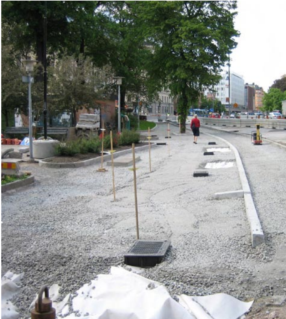
Luft- och dagvattenbrunnar typ Clarova, här med betäckningar i segjärn och packat bärlager. Sträckan innehåller både nya planteringsgropar och ytor som växtbäddsrenoverats för befintliga gatuträd.
