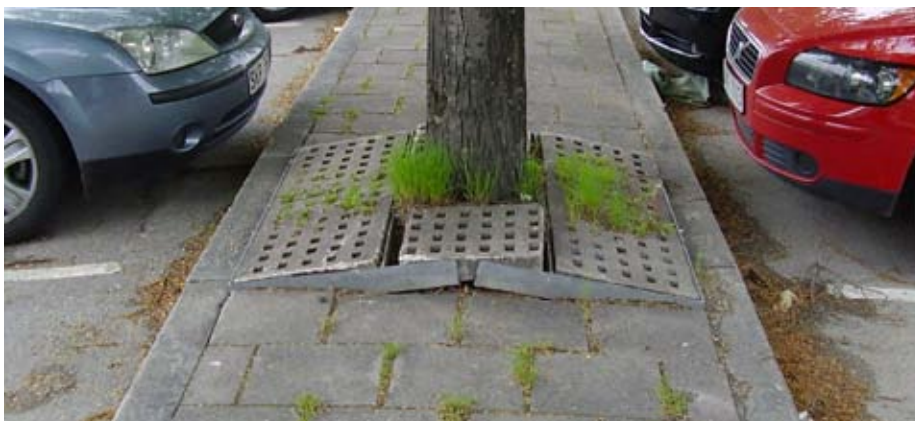
Träd på parkeringar har ofta hårdgjorda ytor alldeles inpå stammen. (Foto: Örjan Stål)
