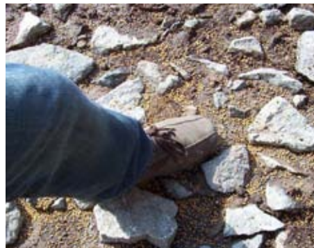
Växtjord typ D vattnas ned i skelettlager. Gödsel läggs ut direkt på skelttvolymen. (Foton: Örjan Stål)
