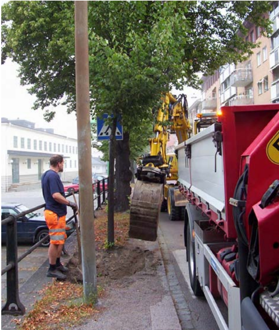
Befintliga lindar med vägöverbyggnad på det gamla rotsystemet. En minimal mittremsa med stensjöl och kantsten har anlagts i trärdagens linje med en bredd som motsvarar diametern på befintliga trädstammar.
