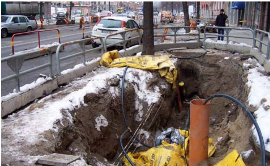
En nyschaktad gångbana nära en parklind på Birjer Jarlsgatan i Stockholm. En vanlig marksituation för stadsträd där ledningsstråk och hårdgjorda ytor anläggs i trädets absoluta närhet. Trädet har utvecklats ett minimalt och kompakt rotsystem. Upprepade schakter och dåliga växtförutsättningar medger små utvecklingsmöjligheter i marken. (Foto: Björn Embrén)
