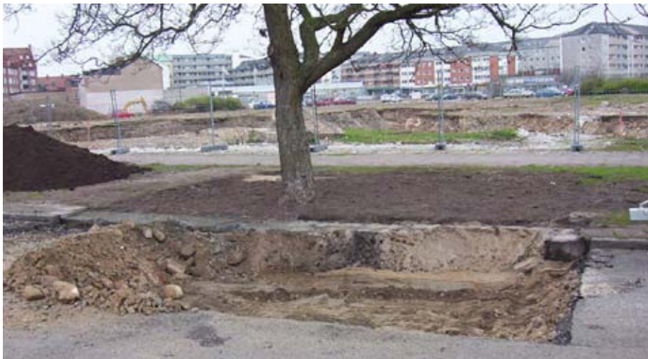
Provschakt i gata nära träd. Inga trädrötter har här påträffats i vägöverbyggnaden.
