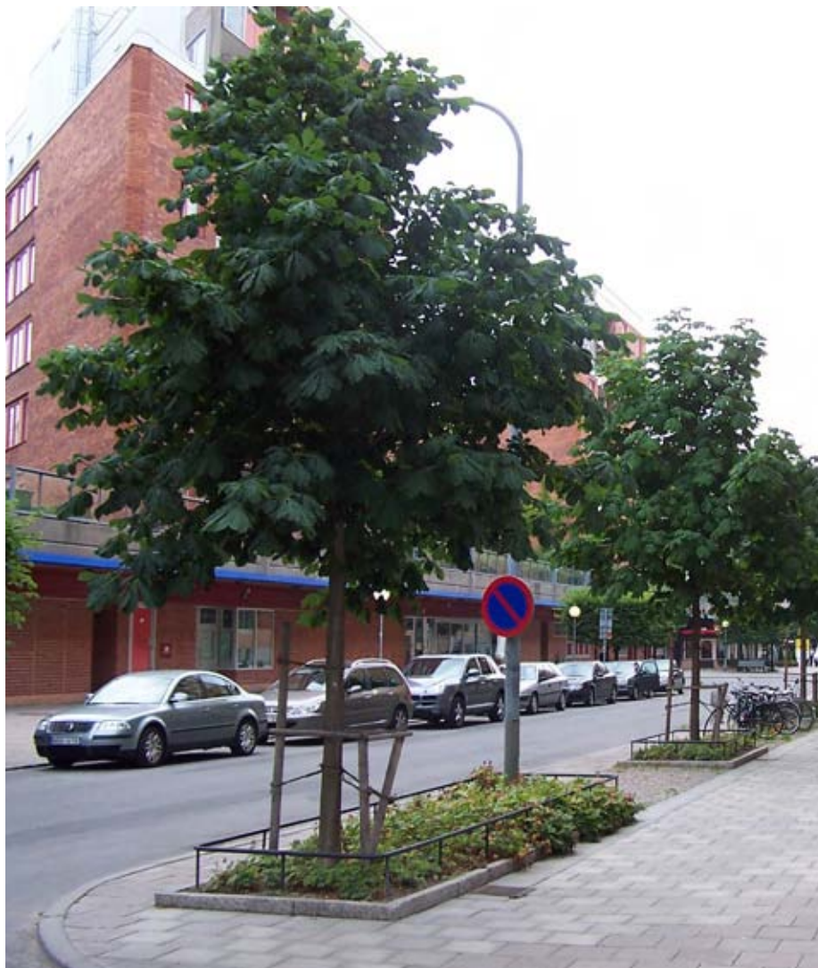
Nyanlagd gångbana med gatuträd i Stockholm. Träden har en underplantering av flocknävor. 15 m 3 skelettjord/ träd och luftigt bärlager är lagd under den hårdgjorda beläggningen. Dagvatten från hustaken leds via skålformade betongrännor till luftnings- och dagvattenbrunnar. (Foto: Björn Embrén)
