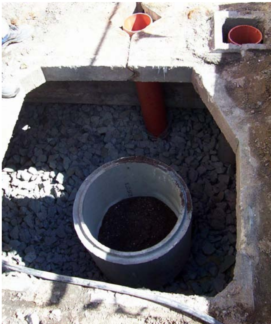
Planteringsförutsättningar för gatuträd i Stockholm längs Klarabergsviadukten. En bunkerliknande betongkonstruktion som fylls med växtjord typ C utgör växtvolym. Fungerande gasutbyte säkerställs via de orange ventilationsrören. Betongringen i mitten säkerställer att trädet inte sätter sig och sjunker ned i jordvolymen. Man fixerar därmed trädets rothals. (Foto: Björn Embrén)
