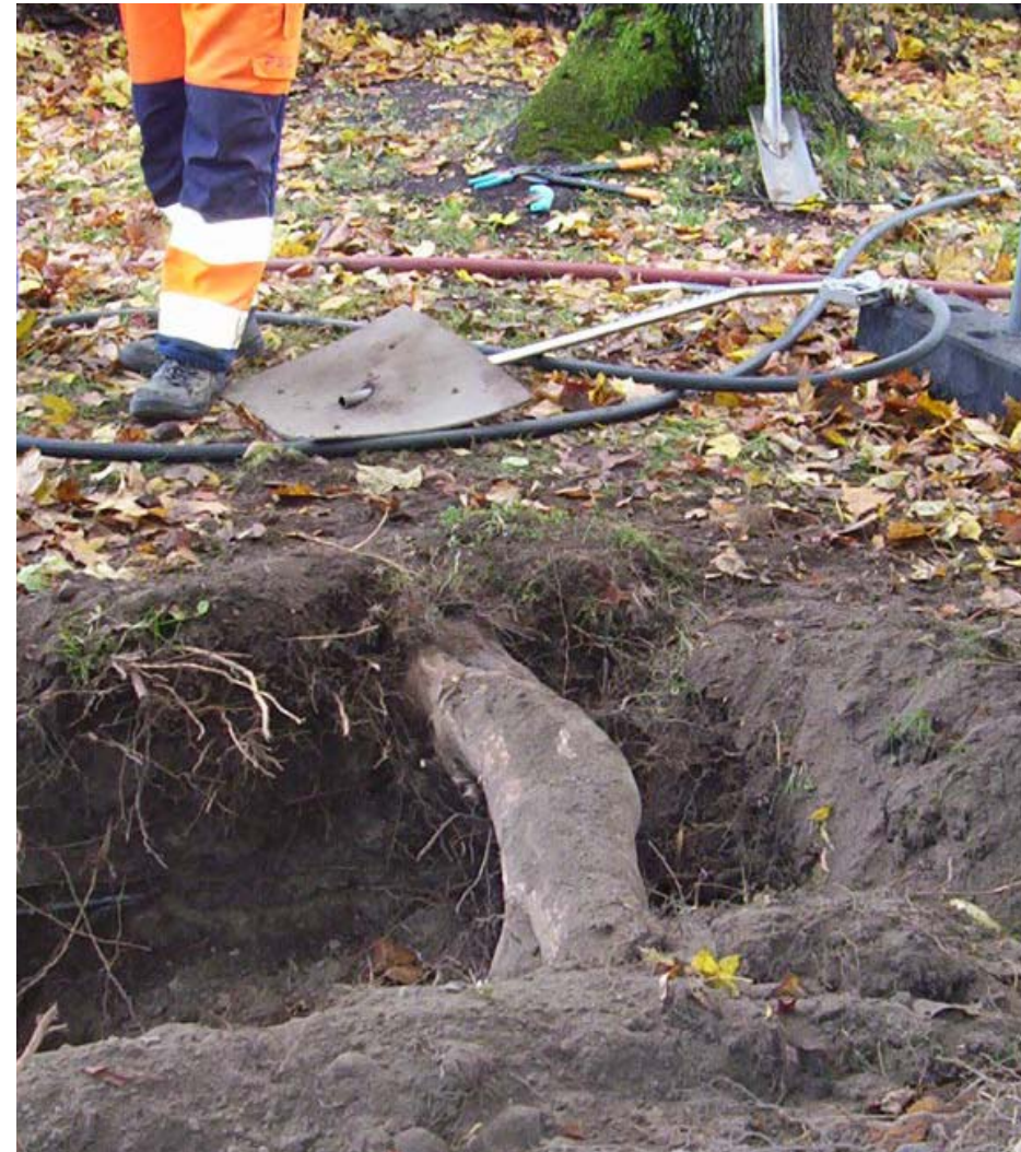
Träd kan i trånga situationer utveckla grova rötter, s.k. pipelines, vilka försörjer trädindividerna med en stor del av dess upptag av näring och vatten. Dessa rötter är viktiga att spara vid växtbäddsrenoveringar. Med vakuumenteknik kan man schakta fram och kartlägga var dessa rötter går utan att skada rotsystemet. Vid traditionell maskinschakt finns en uppenbar risk att skada dessa grova rötter. (Foton: Örjan Stål)
