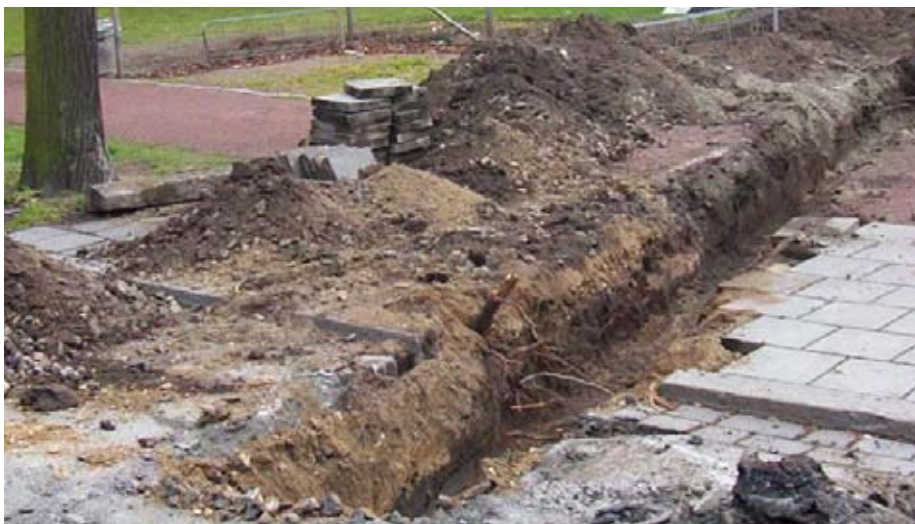
Schaktdike 5 m från trädstam. Felaktigt utfört med avgrävning av grova rötter och inget skydd mot uttorkning. (Foton: Örjan Stål)
