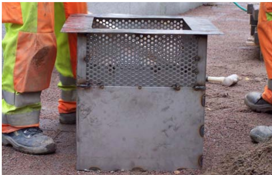
Luftbrunn typ TVL 2333 Clarova. Brunnen placeras direkt ovanpå skelettjorden. Brunnen för ned dagvat- ten i skelettjorden och sörjer samtidigt för lufttillgång vilket möjliggör det för träden livsviktiga gasutbytet i marklagren. Det finns även brunnar på marknaden där hela sidorna perforerats. (Foto: Björn Embrén)
