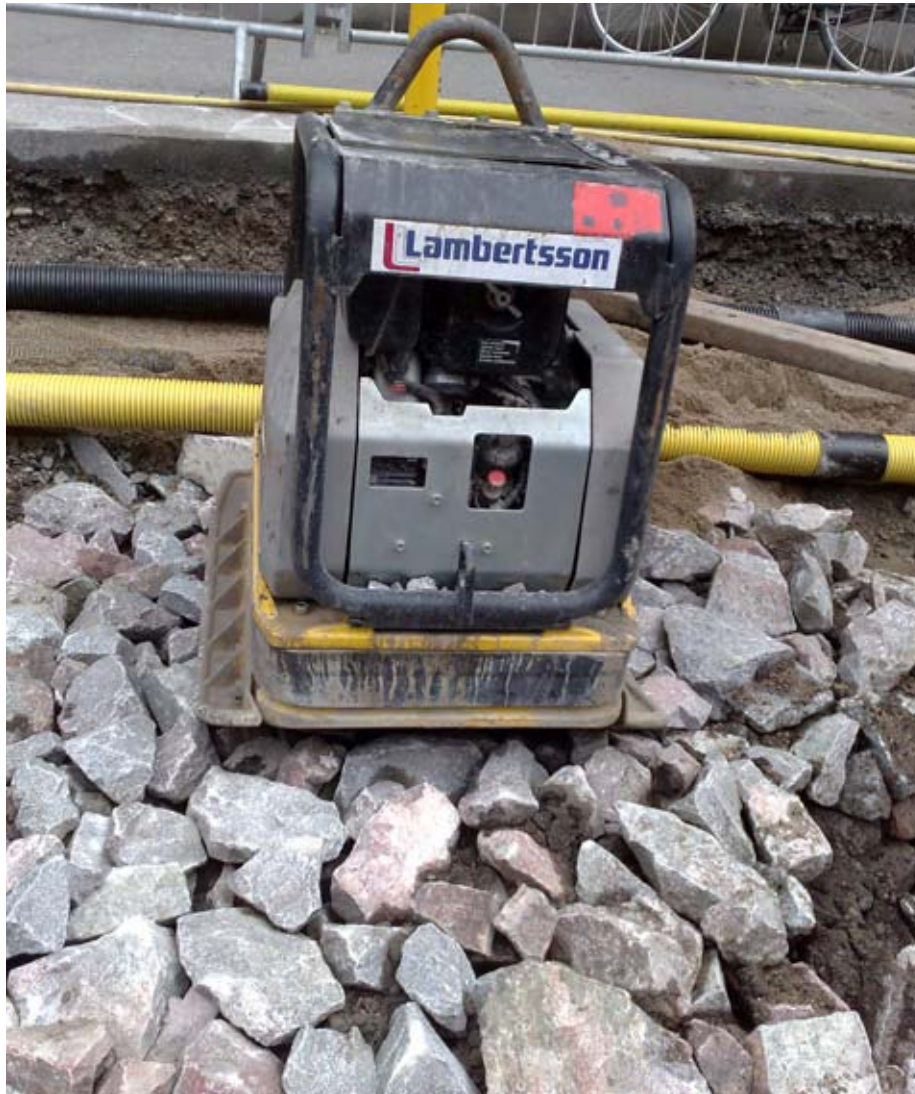
Maskin för komprimering av skelettlager. Bilderna på nästföljande sida illustrerar delar av arbetsgången för skelettjordsanläggning. (Foto: Örjan Stål)
