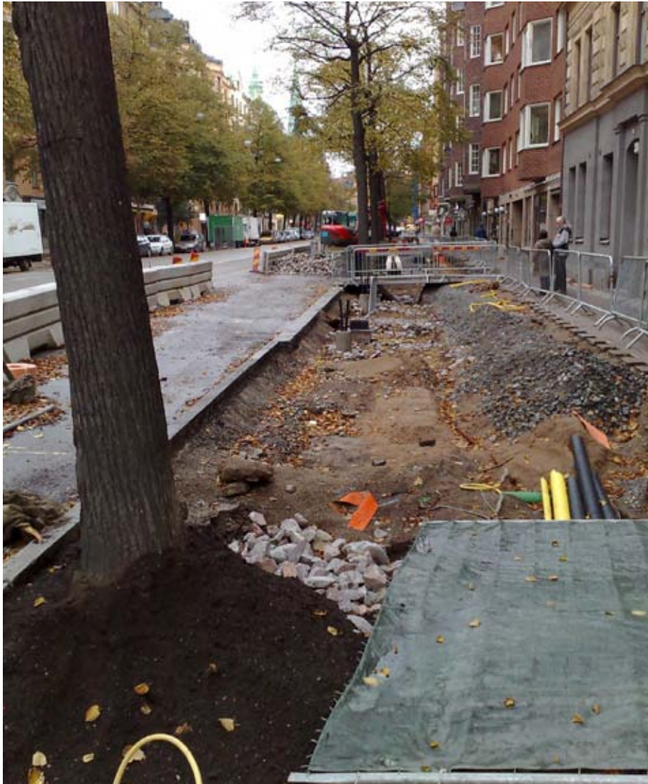
Schaktarbeten på Birjer Jarlsgatan i Stockholm. Växtbäddsrenovering utförs i samband med byggnation av cykelbanor. Befintligt rotsystem skyddas mot uttorkning med utlagd växtjord. (Foto: Örjan Stål)
