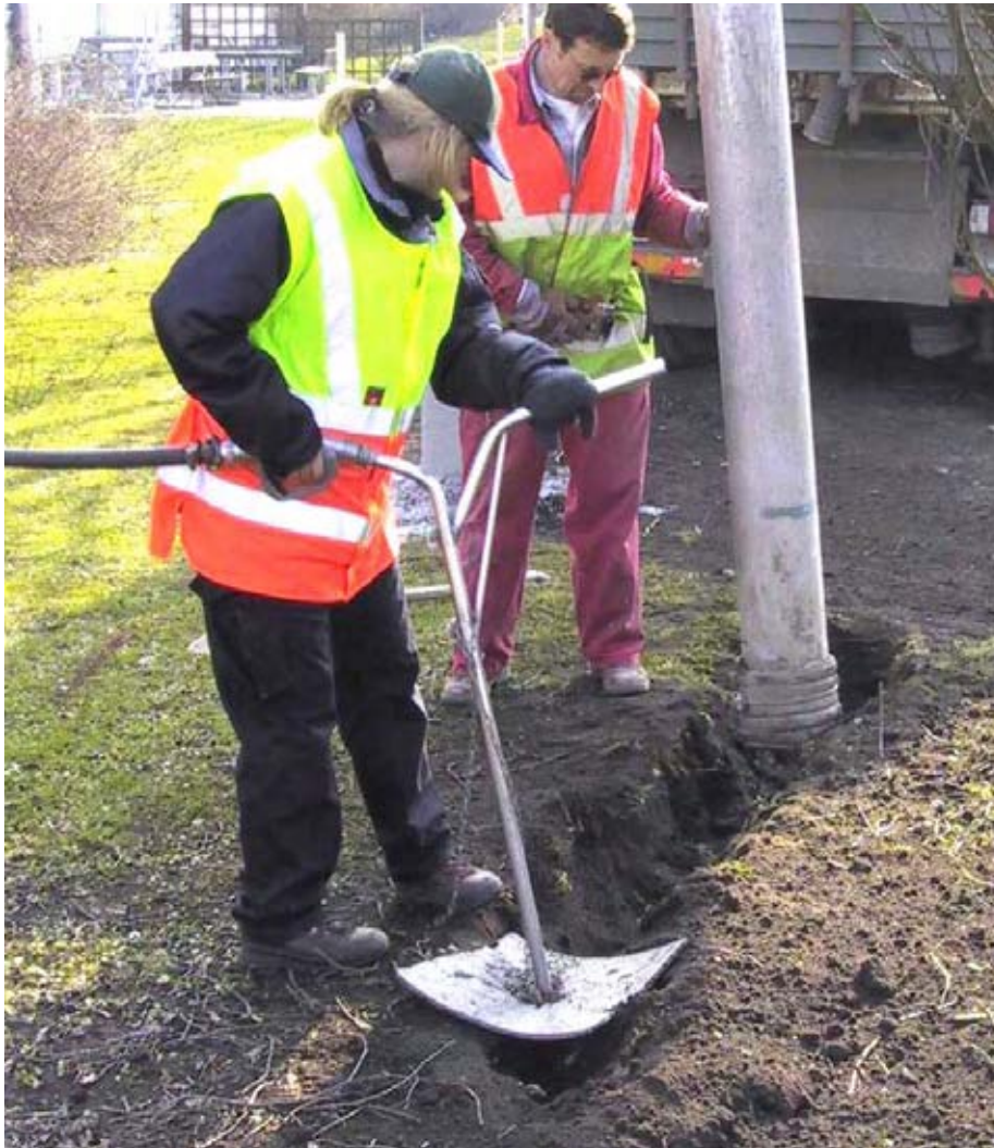
Arbete med vakuumenteknik. Med tryckluftslansen skjuts jorden lös så att den sedan kan sugas upp. Tryckluftslansen används även för luckring av terrass och befintliga kompakterade jordytor.
