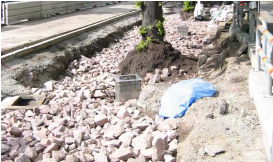
Befintliga gatuträd efter utfört schaktarbete. Utläggning av skelettskärv har påbörjats och luft- och dagvattenbrunnar har placerats ut direkt på skärven. (Foto: Björn Embrén)
