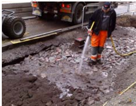
Växtjord typ D vattnas ned i skelettlager. Gödsel läggs ut direkt på skelttvolymen. (Foton: Örjan Stål)
