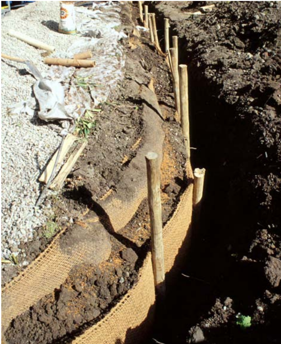
Rotdraperi byggs här av kokosmatta monterad mot träpålar samt fuktig jord. När återfyllnadsarbeten ej kan utföras omgående skyddar rotdraperiet trädrötter från uttorkning.
