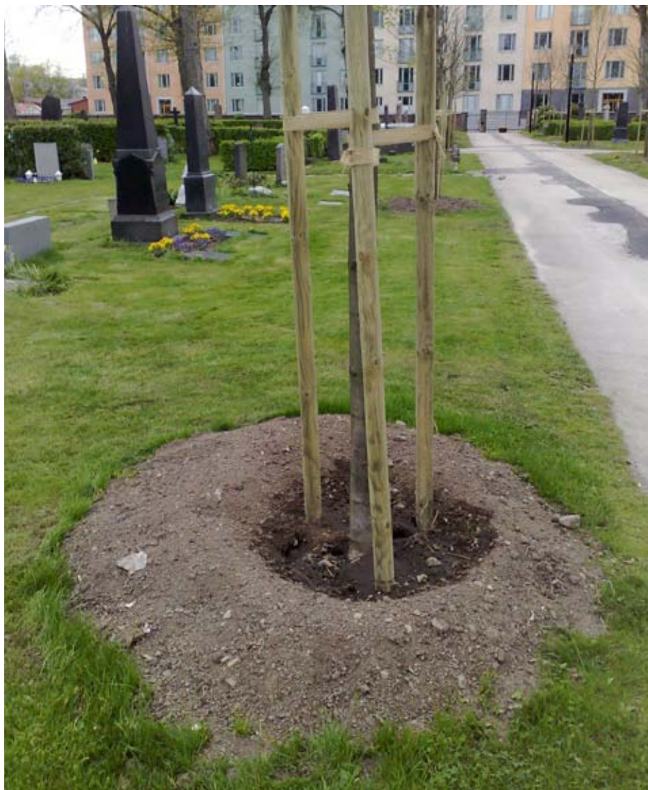
Träd planterat i vegetationsyta med naturlig markprofil. En tillfällig bevattningsvall förenklar bevattningsarbetet. Vattensäck är en annan mycket bra bevattningsmetod, se kap. 5.3. Uppbindningen justeras efter första säsongen med lägre stolphöjd på trädstöden. (Foto: Örjan Stål)
