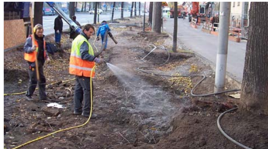
Genom bevattning och utläggning av ny växtjord skyddas det befintliga framschaktade rotsystemet mot torka. (Foton: Björn Embrén)
