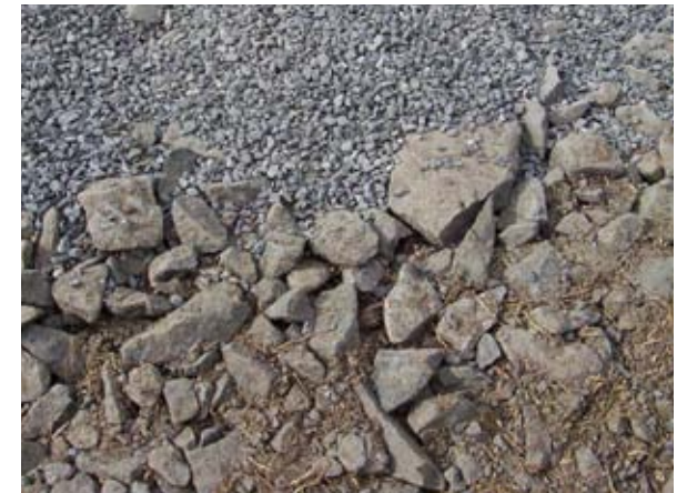
En luftig volym med bärande egenskaper för parkering. Olika låsande lager av makadam läggs ovan på varandra. Makadamlagren minskar successivt i fraktion ju högre upp i profilen de läggs ut. (Foton: Örjan Stål)
