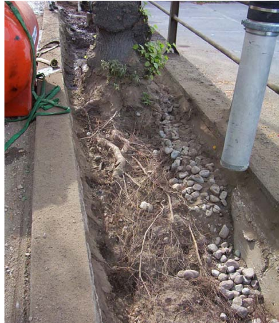
Rotvänlig schakt används här för att skonsamt ta bort överbyggnadsmaterial och blottlägga det befintliga rotsystemet. En tät matta av fint rotsystem tas fram innan återställning av växtbädd med luftig struktur kan återläggas. (Foton: Örjan Ståhl)
