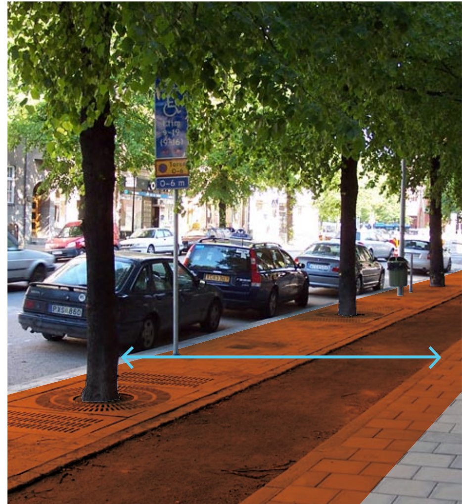
Återställning av nytt ytskikt med betongplattor. Ram för trädgaller läggs på betonglåda eller betongsyl- lar. Den färdiga anläggningen har en rotningsbar växtvolym på 15 m 3 per träd. Orange fält illustrerar ungefärlig bredd på det sammanhängande skelettjordsstråket. (Foton: Björn Embrén)
