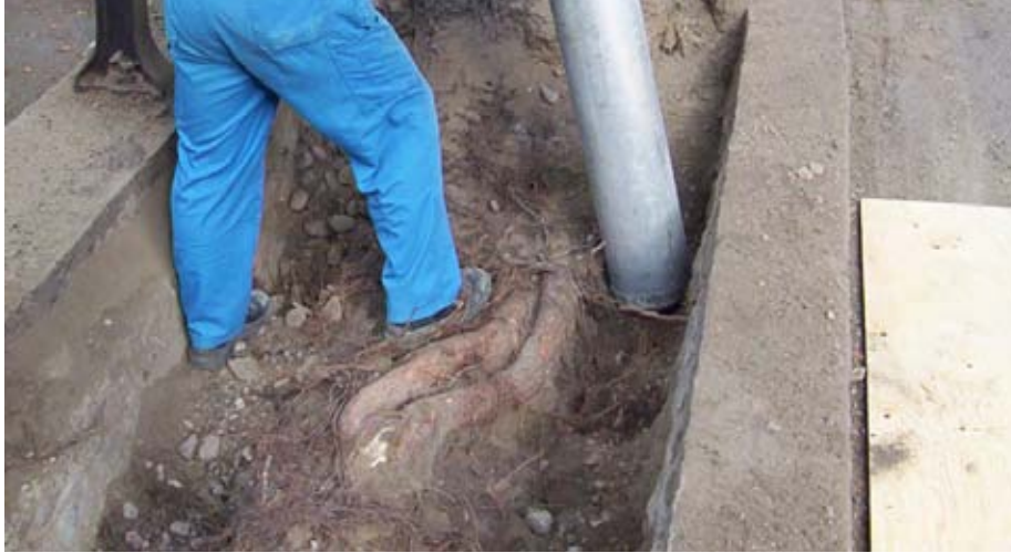
Rotvänlig schakt utförs nära träd och vid påträffande av stora trädrötter. (Foto: Örjan Stål)
