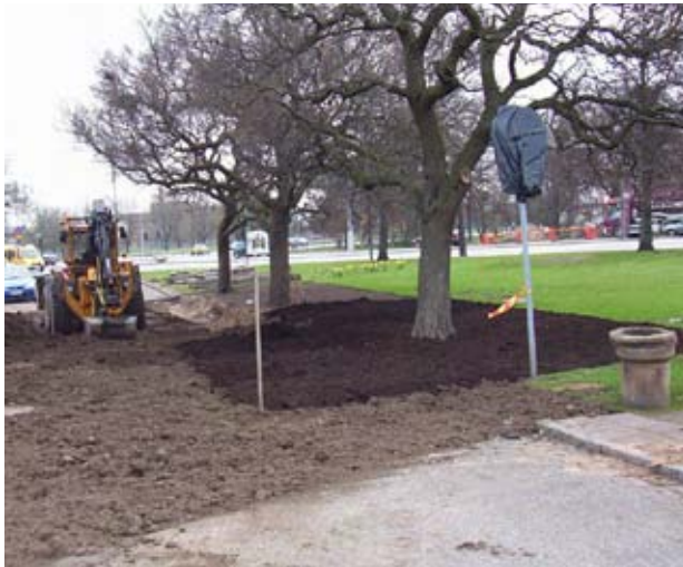
Utläggning av ny växtjord typ A i schaktgropen för gamla vägen. Ett nytt extra näringsrikt lager av mullrik växtjord läggs ut på det luckrade framschaktade rotsystemet. Slutligen färdigställande av ny sammanbunden parkyta med växtbäddsrenoverade ytor.
