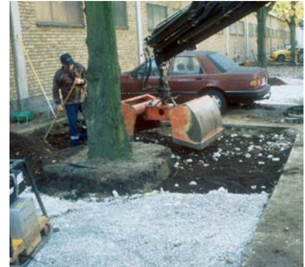
Färdigställande av parkeringsyta med genomsläppligt ytskikt av makadam.
