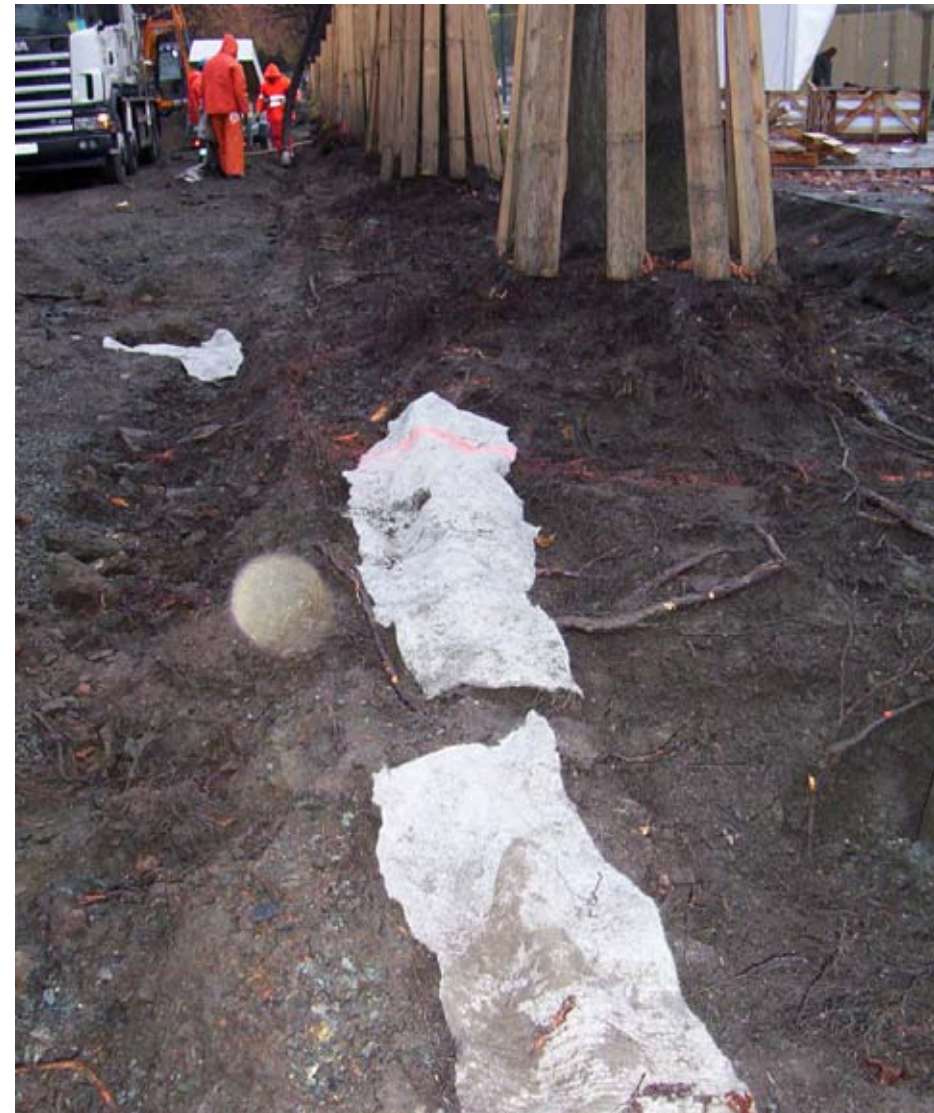
Geotextil utlagd ovanpå grova trädrötter som skydd mot vassa stenar innan återfyllning. (Foton: Örjan Stål)
