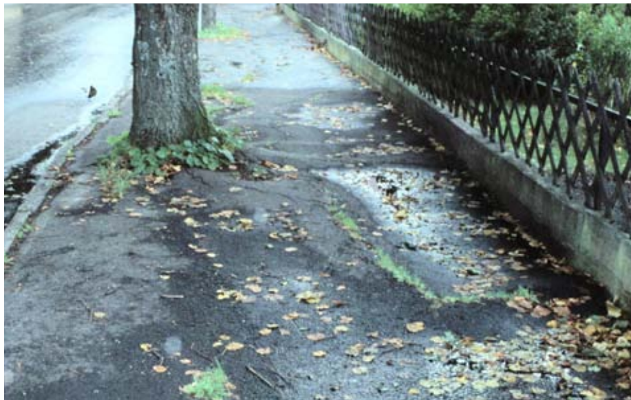
Vid dåliga markförhållanden växer gatuträd där det finns luft och fukt d.v.s i sättsanden direkt under ytskiktet. De med tiden allt grövre rötterna pressar beläggningsytan uppåt och spräcker ytskiktet.
