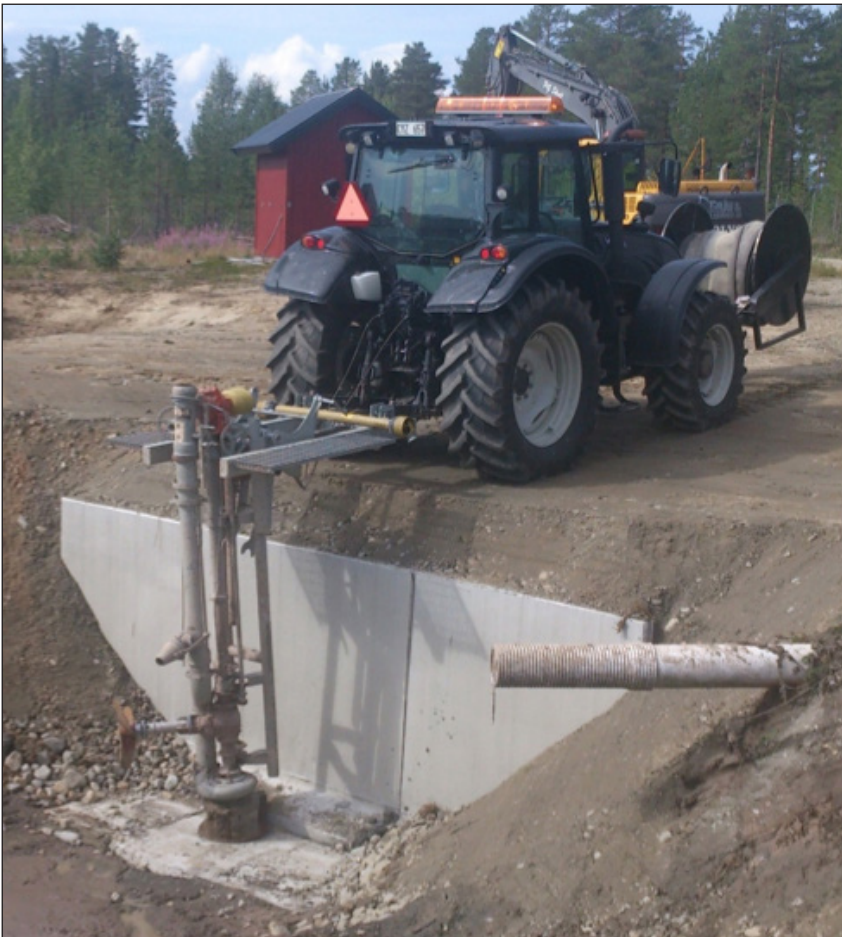
Figur 3-11 Särskild iordninggjord uppställningsplats för traktorburen pumputrustning för slamtömning av sedimentationsdamm (Härjedalens kommun).
