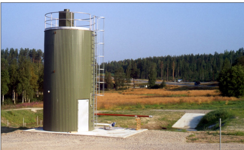
Figur 3-12 Kalksilo med första sedimentationsdamm till höger, utformad med gjuten bottensula och nedfartsramp för tömning med traktor (Myckelgensjö, Örnsköldsviks kommun).
