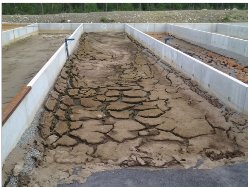
Figur 4-2 Slamfrysbeddar med olika faser av upptorkningsprocessen. Slamkakorna i det högra facket har en TS-halt långt över 50 %. Anläggningstypen förekommer vid reningsverk med kontinuerligt slamuttag (Ramsjö, Ljusdals kommun).
