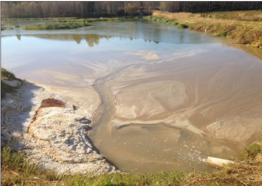
Figur 3-10 Kalkslamavsättning i första delen av sedimentationsdamm efter fällning (Tännedalen, Härjedalens kommun).
