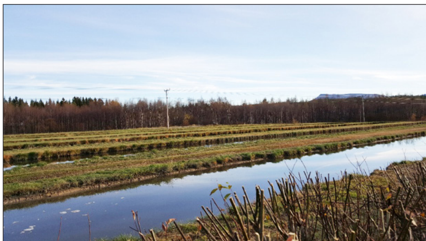
Figur 2-1 Fällningsdamm med avlånga dammformer etablerad på tidigare åkermark (Hede, Härjedalens kommun).
