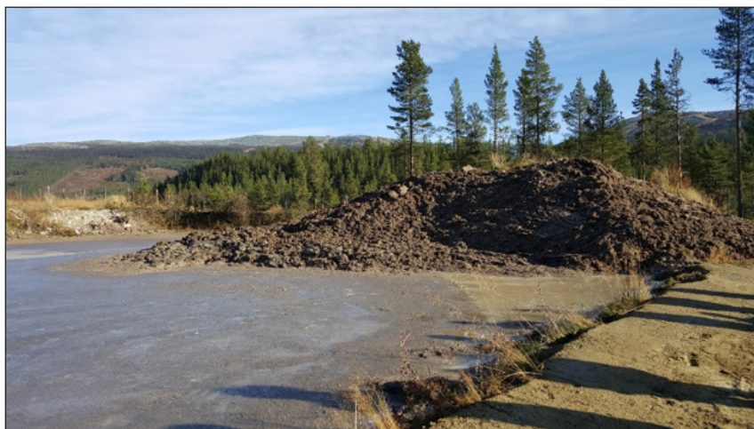
Figur 5-3 Dräneringsdamm för försedimenterat slam med upplag för avvattnat slam från föregående säsong (Vemdalskalet, Härjedalens kommun).
