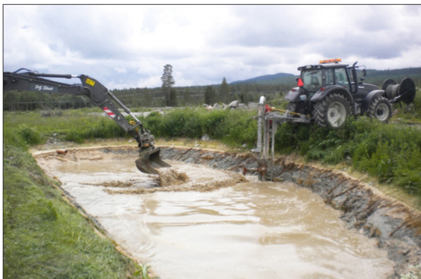
Figur 5-2 Slamtömning genom pumpning. Grävmaskinen homogeniserar slammet så att även bottenlammet följer med vid urpumpningen. Våtslammet leds till slamdräneringsyta. (Härjedalens kommun).
