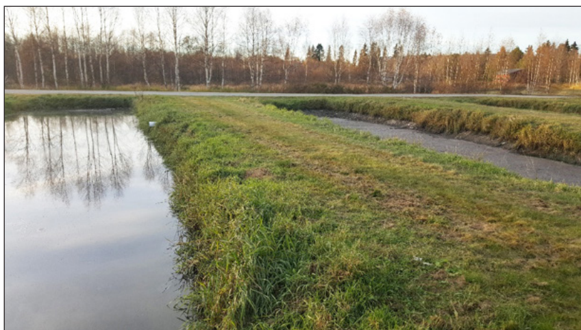
Figur 3-6 Försedimenteringsdammar där rens avskiljs blandat med primärslam. I exemplet är dessa dammar för grovavskiljning små för att underlätta tömning (Hede, Härjedalens kommun).
