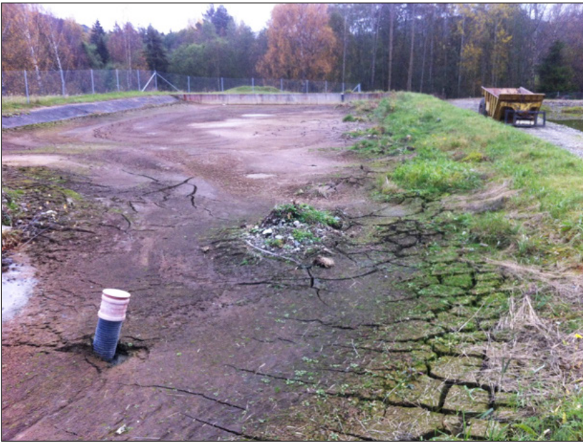
Figur 3-13 Slamtorkbädd dit slammet pumpas från sedimentationsdamm som skymtar till höger. Dräneringsvatten från torkytan rinner med självfall tillbaka till den lägre liggande sedimentationsdammen (Indal, Sundsvall kommun).
