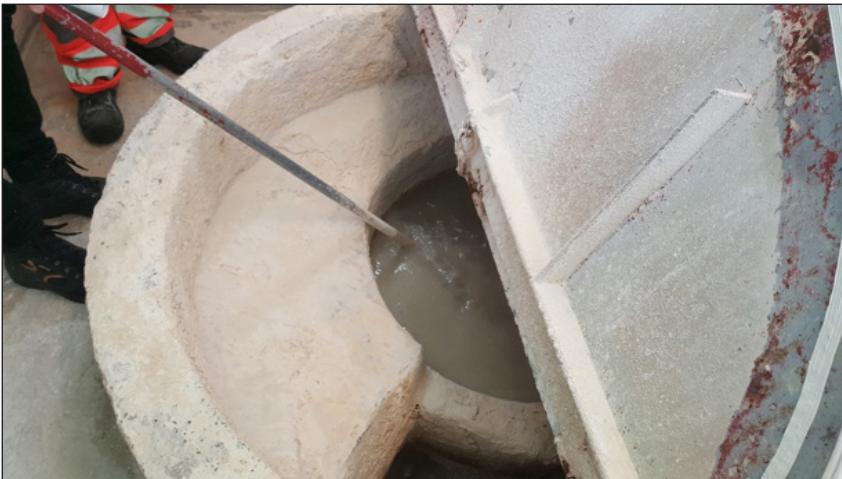
Figur 5-1 Brunn för kalkdosering. Utfällningar av kalciumkarbonat ger hård påbyggnad som kan kräva dagliga insatser för att hållas i schack. (Tännaldalen, Härjedalens kommun).
