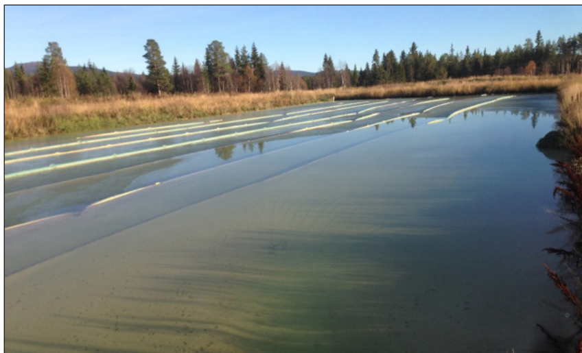
Figur 4-1 Inloppet till sedimentationsdamm som innehåller stora mängder kalkslam som resulterat i att delar av flytskärmarna tyngts ner. Ett erosionsförlopp kan avläsas i det flödesmönster som avtecknats i slammet. (Funäsdalen, Härjedalens kommun).
