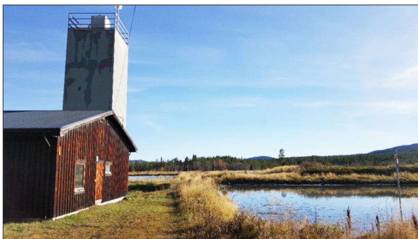
Figur 1-1 Fällningsdammar med doseringsbyggnad och kemikaliesilo (Funäsdalen, Härjedalens kommun).
