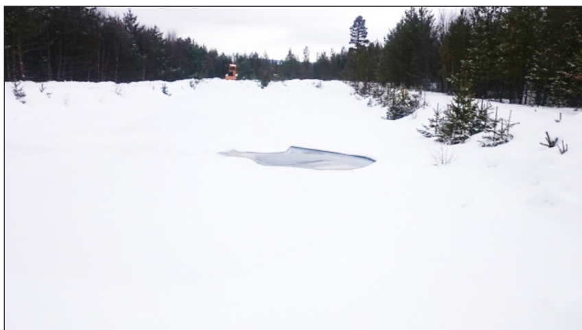
Figur 2-2 Öppen infiltration som slutsteg efter fällningsdammar (Björnrike, Härjedalens kommun).
