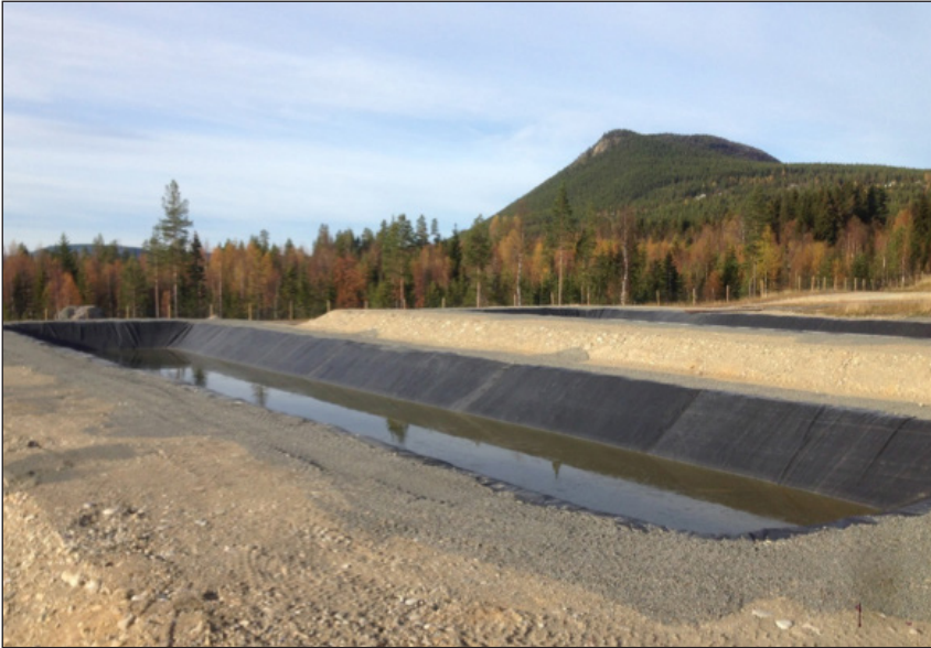
Figur 2-4 Nyanlagda fällningsdammar tätade med syntetiskt geomembran då marken består av genomsläppliga jordarter. Dammarna ligger i ett lutande markparti och är terrasserade (Björnrike, Härjedalens kommun).
