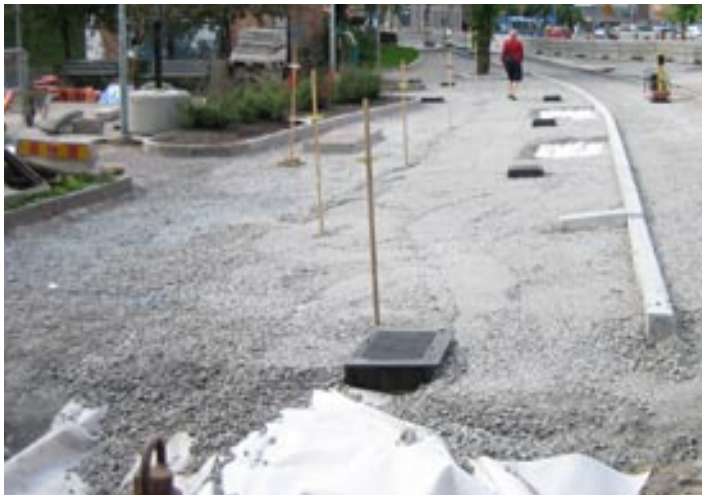
Bilderna visar fortsättning på arbetsgången av skelettjordskonstruktion: nedvattning av växtjord, gödsling av skelettjord, utläggning av luftigt bärlager; utläggning av materialskiljande geotextil och samkross, utplacering av brunnets betäckning för vattenrännor fram till den slutliga utplaceringen av trädgallerram och beläggningsyta
