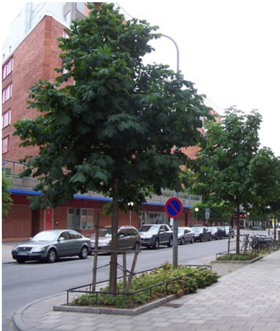
Nyanlagd gångbana med gatuträd i Stockholm. Träden har en underplantering av flocknävor. 15 m 3 skelettjord/ träd + luftigt bärlager är lagd under den hårdgjorda beläggningen. Dagvatten från hustaken leds via skålformade betongrännor till luft- och dagvattenbrunnar.
