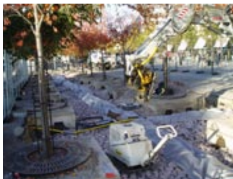
Utläggning av skelettjord sker efter utförd schakt. Observera den utlagda växtjorden som skyddar befintligt rotsystem vid respektive betonglåda. Det är väsentligt att man gräver in i betonglådans öppningar så att man blottlägger befintligt rotsystem.
