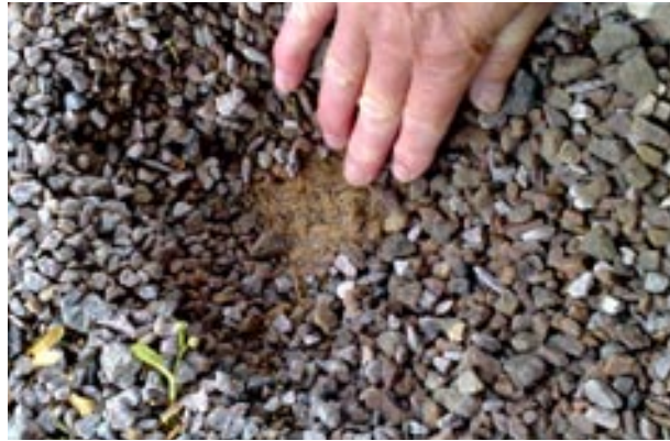
Kokosnät som materialskiljande lager vid ytbeläggning av grus.
