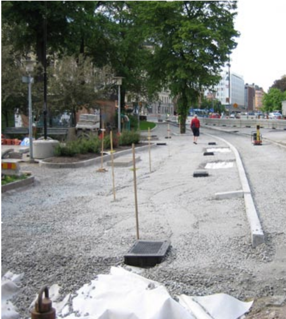
Luft- och dagvattenbrunnar typ Clarova, här med betäckningar och packat bärlager. Sträckan innehåller både nya planteringsgropar och ytor som växtbäddsrenoverats för befintliga gatuträd.
