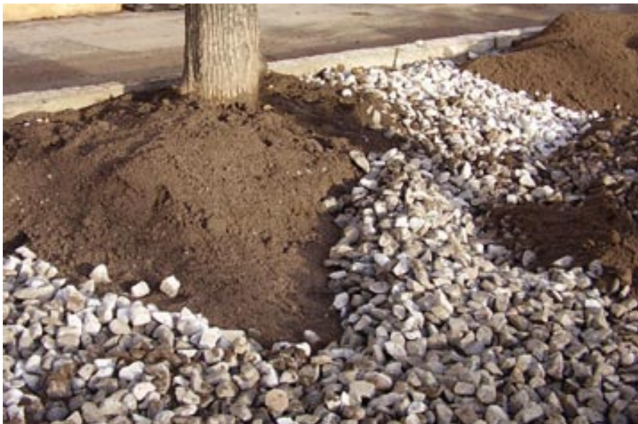
Luftigt lager av makadam 63-90 mm läggs ut på luckrad terrass. Ingen packning sker av makadamlagret. Makadamen ska säkerställa luftighet i den nya jordprofilen. På det luftiga makadamlagret läggs den näringsrika växtjorden ut och vattnas ned.
