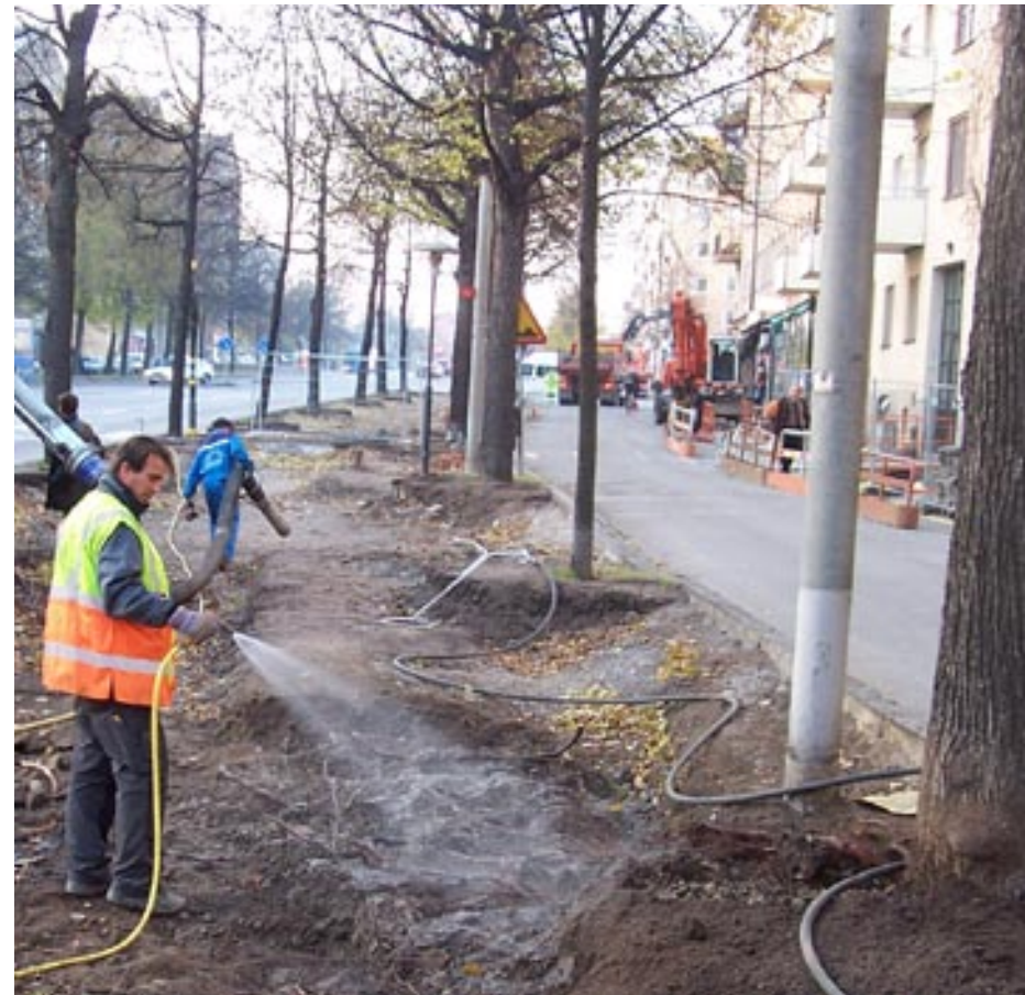
Frilagda rötter bevattas som skydd mot torka vid vakuumschakt.
