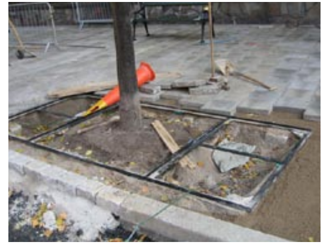
Bilderna visar fortsättning på arbetsgången av skelettjordskonstruktion: nedvattning av växtjord, gödsling av skelettjord, utläggning av luftigt bärlager; utläggning av materialskiljande geotextil och samkross, utplacering av brunnets betäckning för vattenrännor fram till den slutliga utplaceringen av trädgallerram och beläggningsyta
