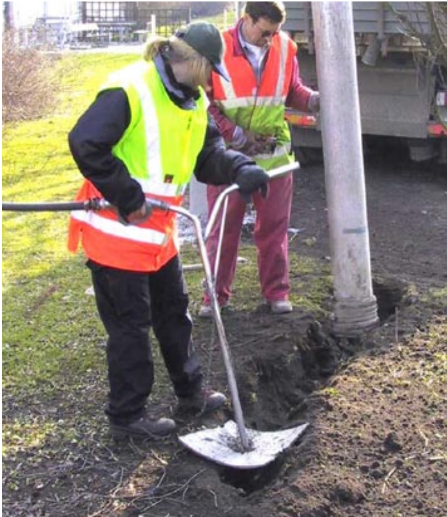
Arbete med vakuumteknik. Med tryckluftslansen skjuts jorden lös så att den sedan kan sugas upp. Tryckluftslansen används även för luckring av terrass och befintliga kompakterade jordytor.
