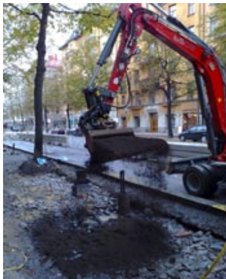
Utläggning av skelettjord för träd i hårdgjord yta. Bilderna visar skelettstruktur med luftigt bärlager, luftbrunn typ TLV 2333 Clarova med betäckning, utläggning av växtjord typ D samt utlagt luftigt bärlager vid luftbrunn.
