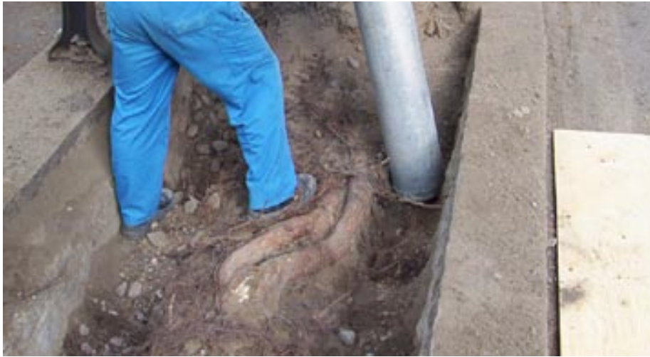
Rotvänlig schakt utförs nära träd och vid påträffande av stora trädrötter.
