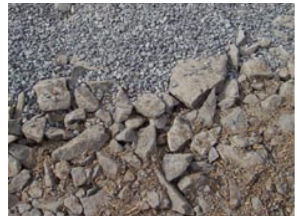
En luftig volym med bärande egenskaper för parkering. Olika låsande lager av makadam läggs ovan på varandra. Makadamlagren minskar succesivt i fraktion.
