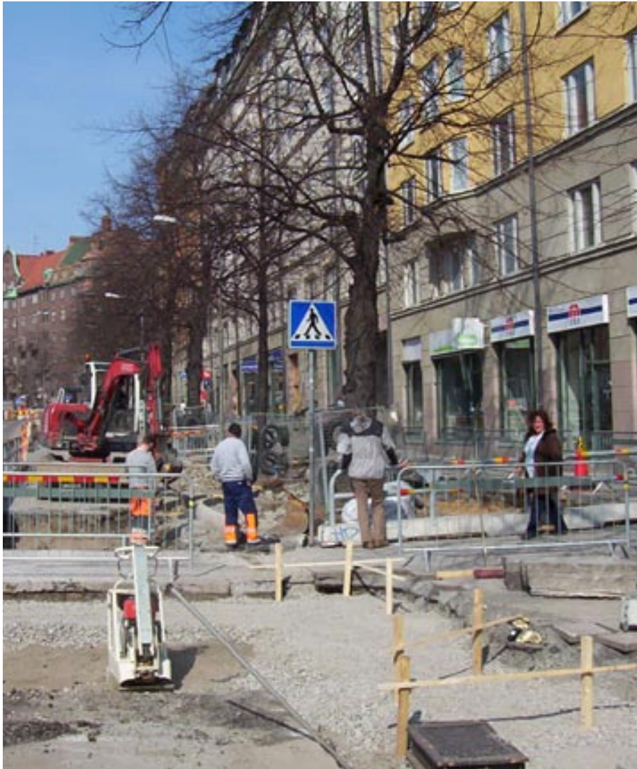
Schaktarbeten på Birger Jarlsgatan i Stockholm. Växtbäddsrenovering i samband med byggnation av cykelbanor.
