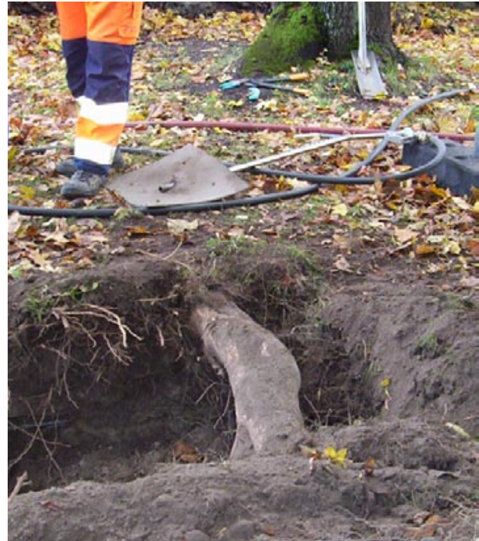
Träd kan i trånga situationer utveckla grova rötter; s k pipelines, vilka försörjer trädindividen med en stor del av dess upptag av näring och vatten. Dessa rötter är viktiga att spara vid växtbäddsrenoveringar. Med vakuumteknik kan man schakta fram och kartlägga var dessa rötter går utan att skada rotsystemet. Vid traditionell maskinschakt finns en uppenbar risk att skada dessa grova rötter.
