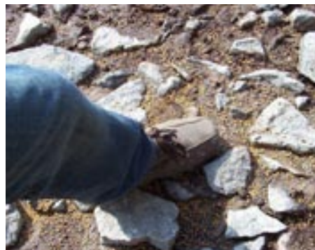
Växtjord vattnas ned i skelettlager. Gödsel och lägg ut på direkt på skelttvolymen.
