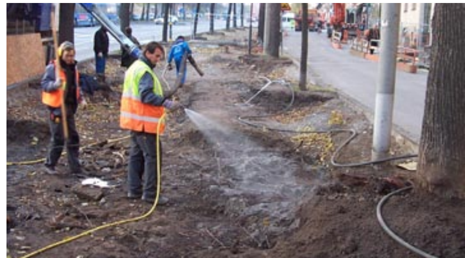
Genom bevattning och utläggning av ny växtjord skyddas det befintliga framschaktade rotsystemet mot torka.
