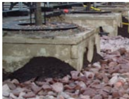
Utläggning av skelettjord sker efter utförd schakt. Observera den utlagda växtjorden som skyddar befintligt rotsystem vid respektive betonglåda. Det är väsentligt att man gräver in i betonglådans öppningar så att man blottlägger befintligt rotsystem.
