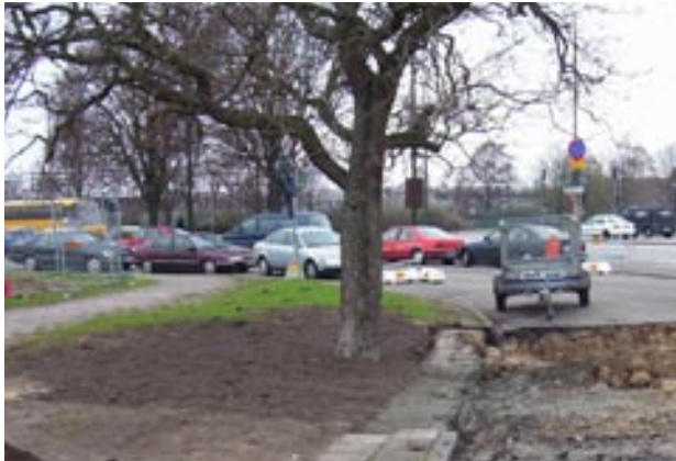
Befintliga hagtorntrod i Malmö vid en gammal väg. Vägen ska tas bort och ett sammanhängande parkstråk ska byggas. Vid provgrävning påträffas inga trärötter i vägbansens överbyggnad. Maskinschakt kan då användas för att ta bort resterande vägöverbyggnad.
