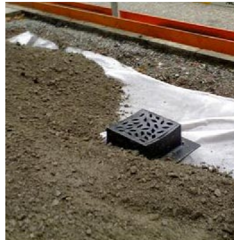
Bilderna visar fortsättning på arbetsgången av skelettjordskonstruktion: nedvattning av växtjord, gödsling av skelettjord, utläggning av luftigt bärlager; utläggning av materialskiljande geotextil och samkross, utplacering av brunnets betäckning för vattenrännor fram till den slutliga utplaceringen av trädgallerram och beläggningsyta
