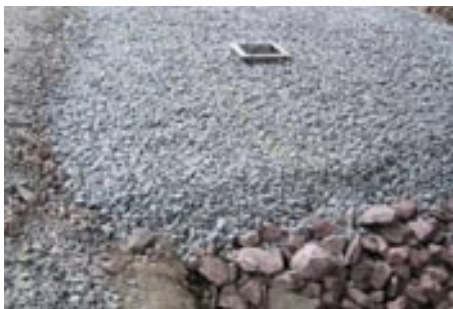
Luftigt bärlager utlagt kring luftbrunn. Geotextil läggs ut innan samkross och beläggning påförs.
