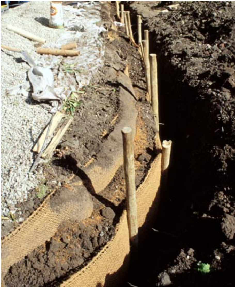
Rotdraperi. Med hjälp av kokosmattor, fuktig jord och träpålar skyddas befintliga trädrötter vid öppen schakt.
