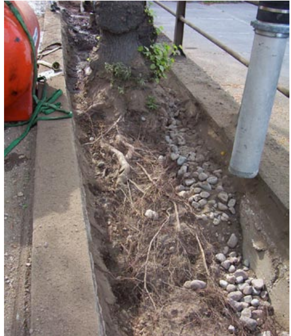
Rotvänlig schakt används här för att skonsamt ta bort överbyggnadsmaterial och blottlägga det befintliga rotsystemet. En tät matta av fint rotsystem tas fram innan återställning av växtbädd med luftig struktur kan återläggas.
