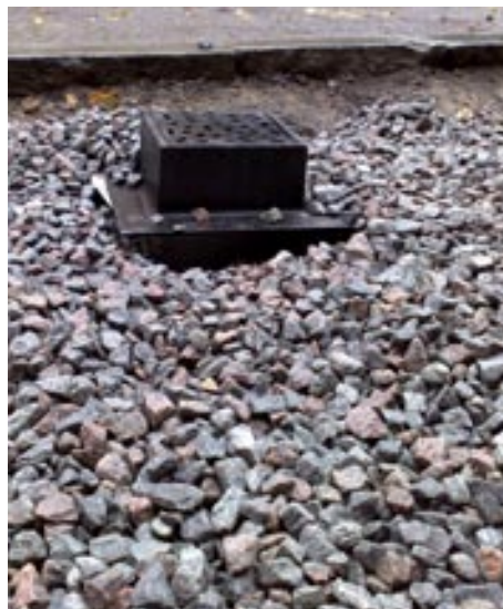
Utläggning av skelettjord för träd i hårdgjord yta. Bilderna visar skelettstruktur med luftigt bärlager, luftbrunn typ TLV 2333 Clarova med betäckning, utläggning av växtjord typ D samt utlagt luftigt bärlager vid luftbrunn.
