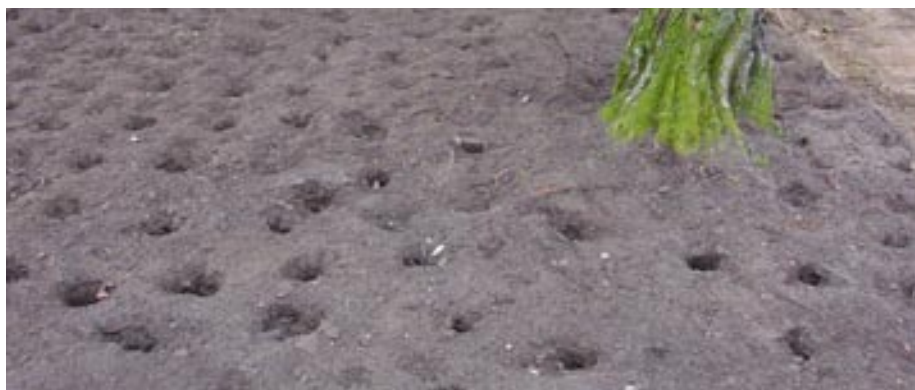
Terrass luckrad med tryckluft. I detta fallet en luckring i ett befintligt tätt rotsystem.
