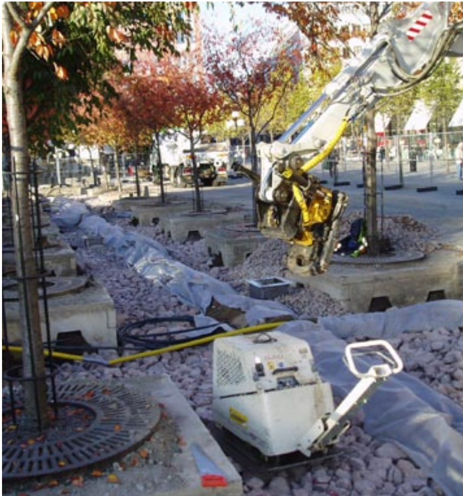
Bilderna redovisar arbetsgång för skelettjordsuppbyggnad. Arbetet inleds med schakt därefter utläggning och komprimering av makadamlager för skelettvolymen, skydd av befintliga ledningar, utplacering av luftbrunnar (fortsättning på nästa sida...)
