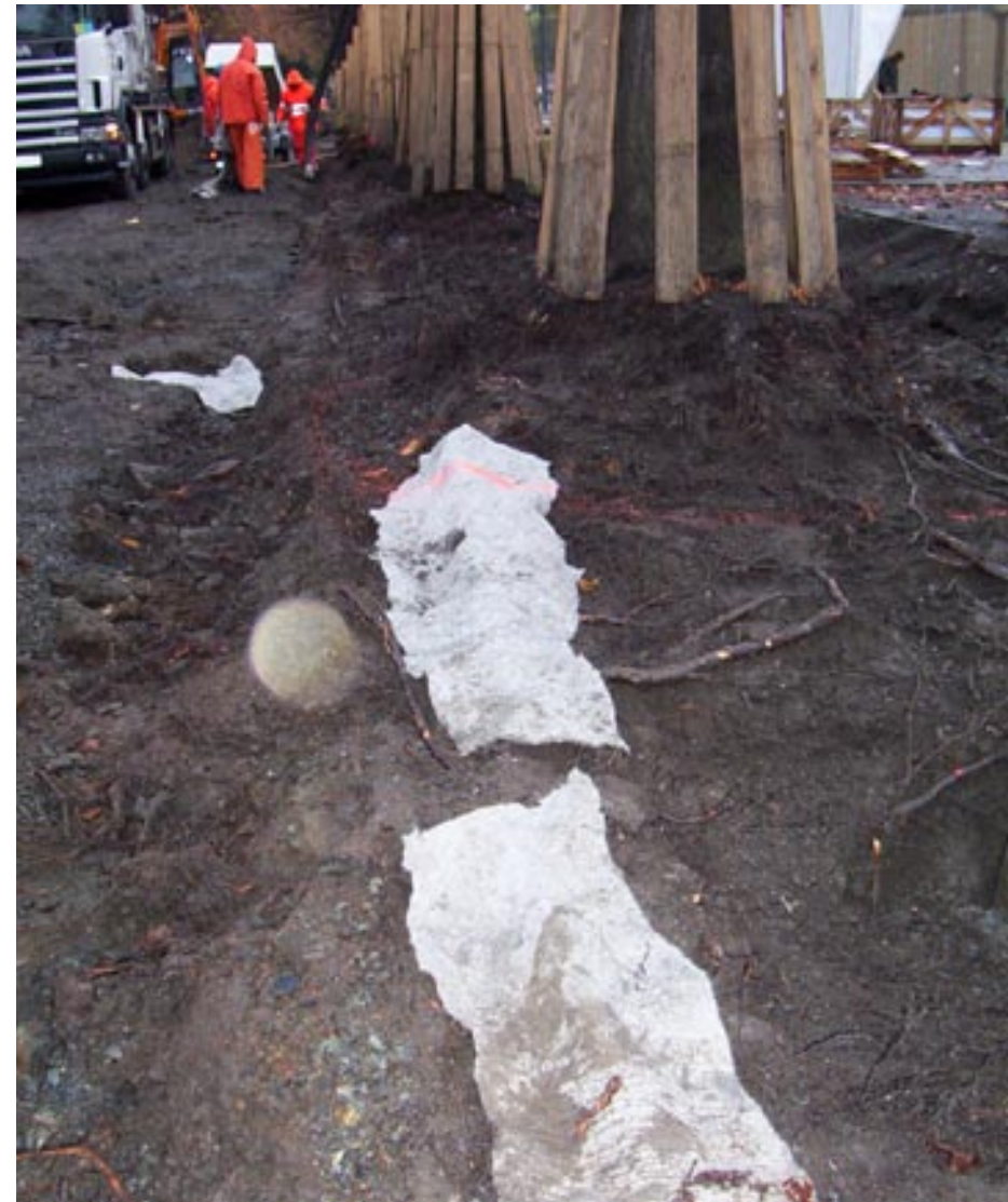
Geotextil utlagd ovanpå grova trädrötter innan återfyllning som skydd mot vassa stenar.
