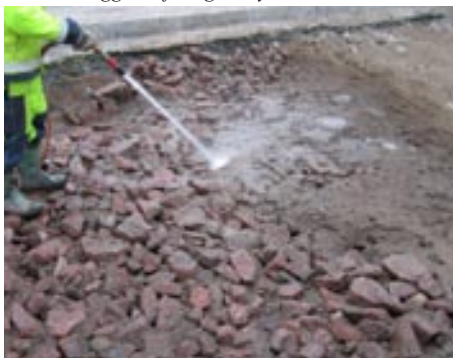
Växtjord vattnas ned i skelettlager. Gödsel och lägg ut på direkt på skelttvolymen.
