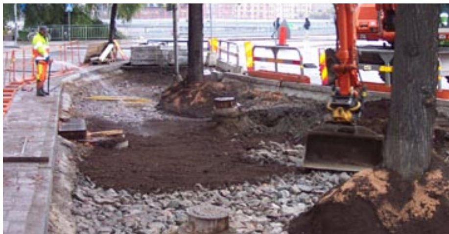
Nedvattnings av växtjord typ D i skelettskär.
