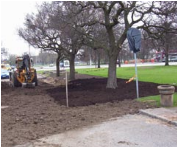
Utläggning av ny växtjord typ A i schaktgropen för gamla vägen. Ett nytt extra näringsrikt lager av mullrik växtjord läggs ut på det luckrade framschaktade rotsystemet. Slutligen frädigställande av ny sammanbunden parkyta med växtbäddsrenoverade ytor.
