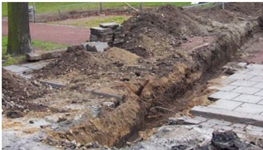
Schaktdike 5 m från trädstam. Felaktigt utfört med avgrävning av grova rötter och inget skydd mot uttorkning.
