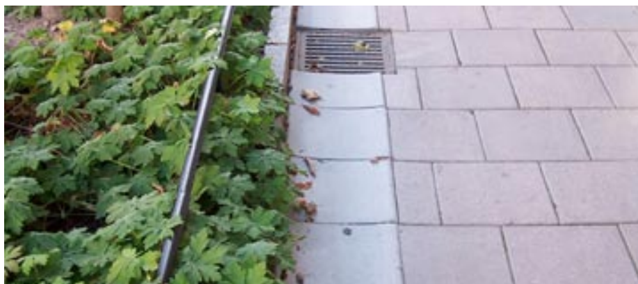
Dagvatten förs här ned till brunn placerad vid planteringsytan. Vattenrännan är lagd som lågpunktslinje med skälade betongplattor. Brunnen är en sk luftbrunn av typen Clarova och förser träden med såväl vatten som luft.
