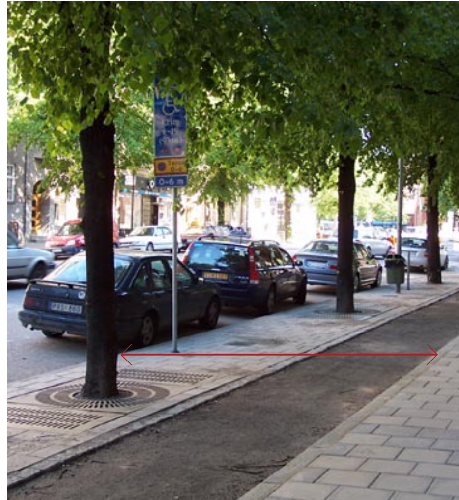
Återställning av nytt ytskikt med betongplattor. Ram för trädgaller läggs på betonglåda eller betongsyllar. Den färdiga anläggningen med nya trädgaller och en rotningsbar växtvolym på 15 m 3 per träd. Röd linje visar skelettjordens utbredning i sidled.
