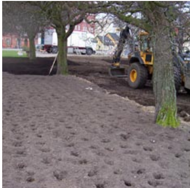
Tryckluftslans används dels för att skjuta loss jord vid rotvänlig schakt och dels för att luckra den gamla parkytan. Framschakat rotsystem skyddas med utlagd växtjord.
