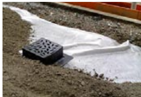
Luftigt bärlager utlagt kring luftbrunn. Geotextil läggs ut innan samkross och beläggning påförs.
