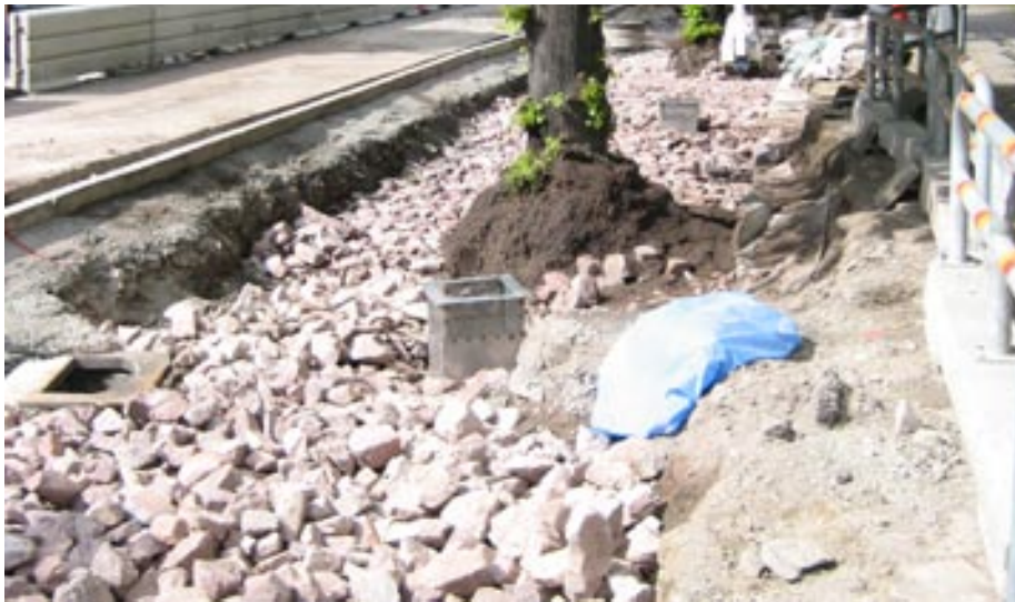
Befintliga gatuträd efter utförd schaktarbete. Utläggning av skelettskärv har påbörjats och luft- och dagvat-tenbrunnar har placerats ut direkt på skärven.
