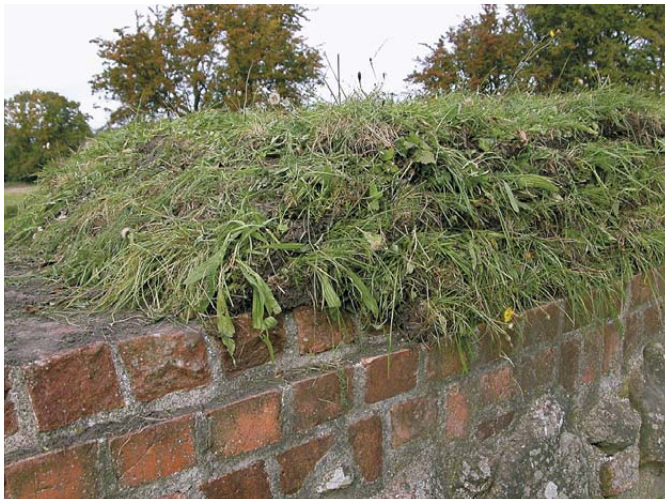
Fyra lager med gräs har använts till avtäckning av murkrönet. Foto: Robert Danielsson.
