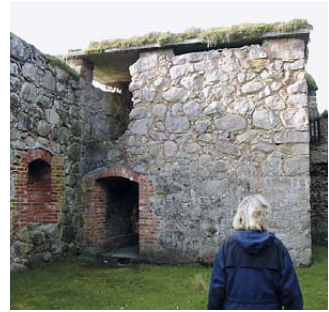
Skyddstaket på Kronobergs slottsruin i Småland ligger fritt ovanpå murarna vilket ger god ventilation och belastar murarna minimalt. Taket märks knappt alls från marken. Foto: Robert Danielsson.
