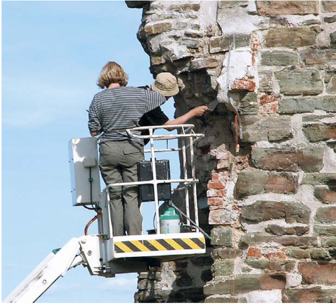
Skadeinventering med skylift. Foto: Henrik Lindblad.
