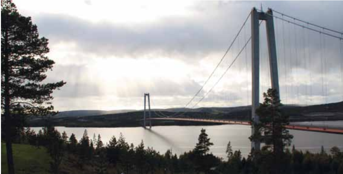
Höga Kusten-bron, en del av projektet Höga Kusten, ett väldigt vägbyggnadsprojekt i bitvis svårt terräng. Foto: Ylva Nordin.
